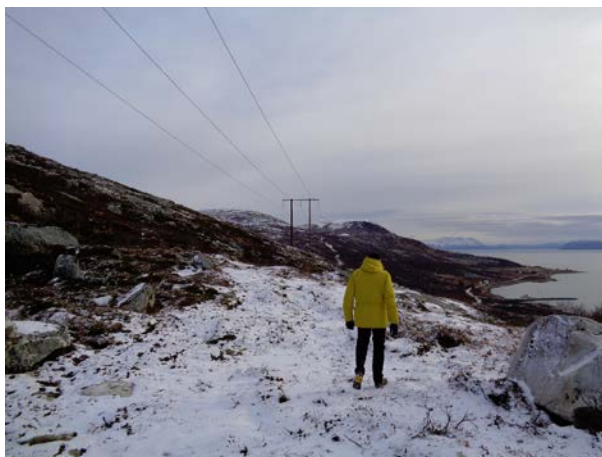
Anleggsvei langs Fakken-linja
