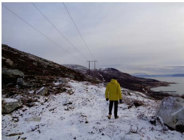
Anleggsvei langs Fakken-linja
